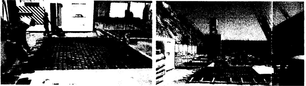
Foto 03 y 04: Acero de refuerzo  $f_y=4200\text{kg/cm}^2$  , losas de PATIO DE MANIOBRAS
