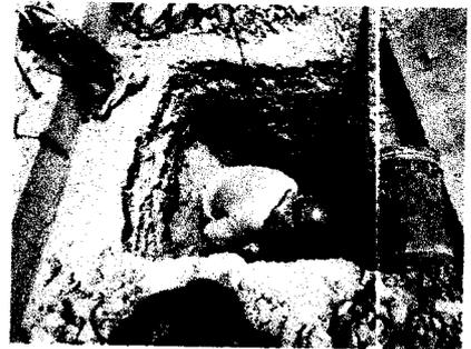
Foto 27, 28 y 29: Instalaciones de tuberías sanitarias para agua fría, estas instalaciones se hacen con proceso constructivo en coordinación con supervisor. También se hace sus respectivas pruebas hidráulicas como manda en las especificaciones técnicas. PATIO DE MANIOBRAS – VEREDAS
