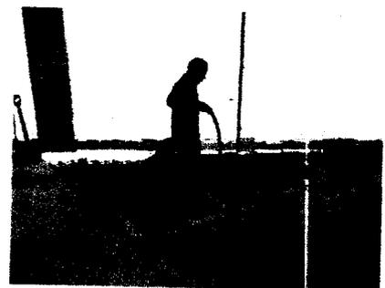
Foto 07, 08 y 09: Vaciado de concreto  $f'c= 315 \text{ kg/cm}^2$ , en patio de maniobras. Algunas losas que van pegadas al cerco perimétrico tienen forma de triángulo. PATIO DE MANIOBRAS
